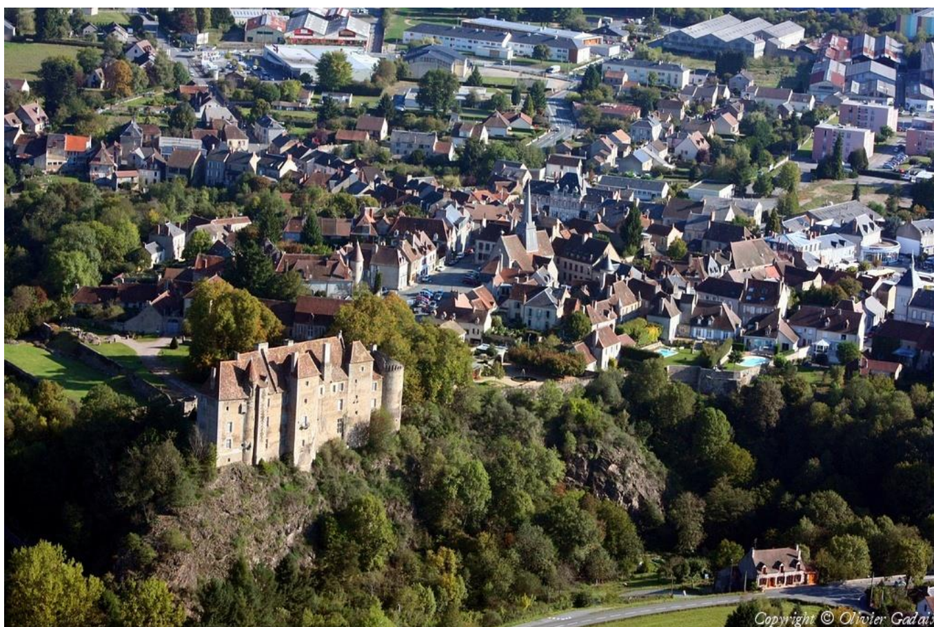
Photo 1 : Vue aérienne de Bousac et son château
