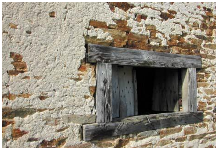
Enduit à la chaux sur façade « en lit » de paragneiss et encadrement en bois de châtaignier
