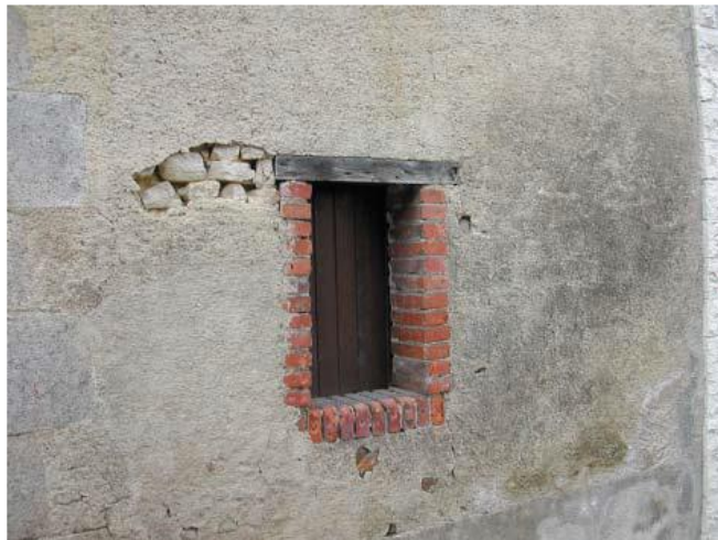
Encadrement mixte de brique et bois de châtaignier
